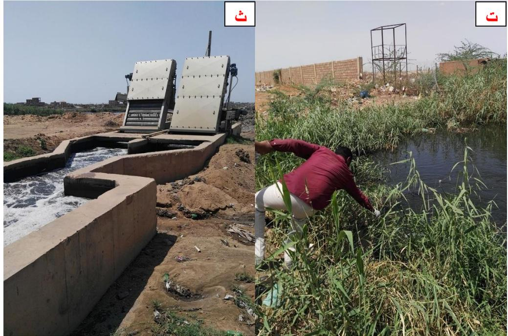
الشكل 2 يوضح رصد الزيارة الميدانية. (أ) عملية تفريغ مياه الصرف الصحي من التناكر، (ب) الأنبوب الناقل لمياه الصرف الصحي من منطقة الرميلة ويري، (ت) حوض التنقية قبل البرك الهوائية، (ث) عملية أخذ العينات من القناة الناقلة للمياه المعالجة.
